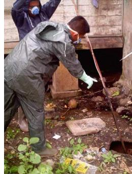
*Sludge measurement/ Pengukuran Tinggi Lumpur*
